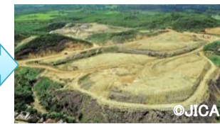
覆土によるごみの飛散・流出を防止
