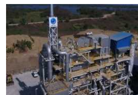
(例) 廃棄物発電施設
